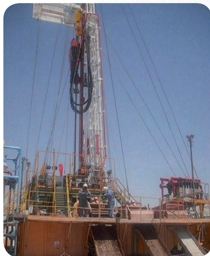
Forage de développement à Bir B. Tartar
